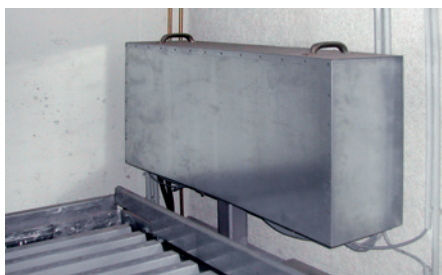
Schallschutzhaube für das Aggregat
