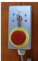
Bedieneinheit bestehend aus Schüsselschalter mit Not-Aus in Totmannsteuerung und mit Verdrahtung zum Hydraulikaggregat.
