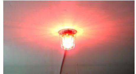
Die Blitzleuchte signalisiert, dass die Anlage in Betrieb ist und gibt dem Nutzer als auch den Personen in der Nähe der Anlage mehr Sicherheit beim Benutzen. Eine Blitzleuchte kann bis für 2 Anlagen benutzt werden.
