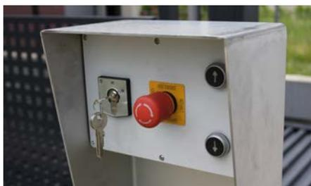
Bedieneinheit bestehend aus einem verriegelbaren Schlüsselschalter (Schlüssel nur bei Abgesenkten Plattformen abziehbar) mit Not-Aus in Totmannsteuerung. Heben und Senken durch entsprechende Taste.
