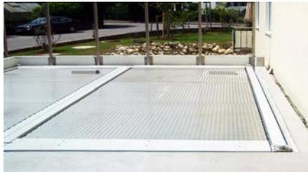
Obere Plattformen mit Fahrblechen aus Aluminium-Tränenblech und Spezialanfahrkeil zur Fahrzeugpositionierung.
