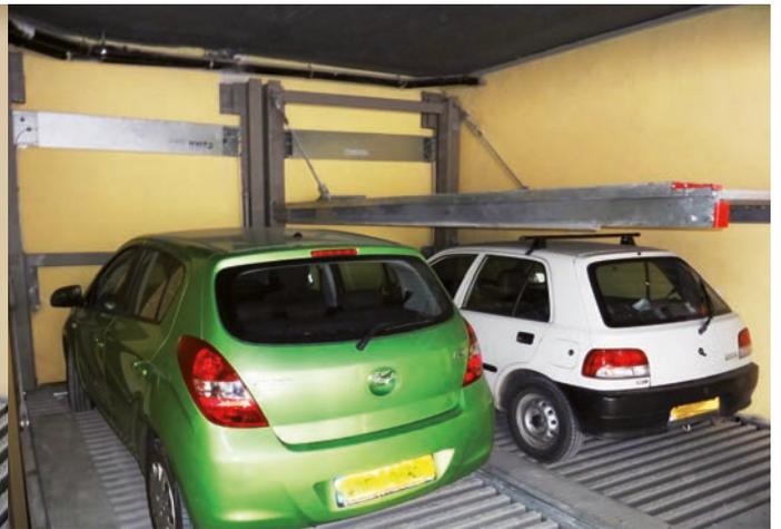
Zwei Einzelanlagen: Eine abgesenkte und eine gehobene Anlage.
